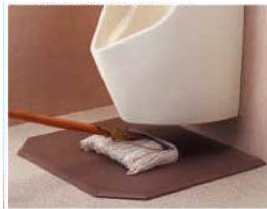
圖 3-26 小便器下方之清掃空間
