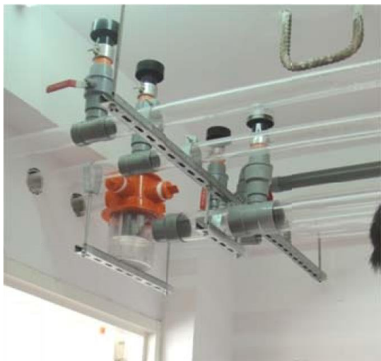
圖 11 排水橫支管負壓現象測試
