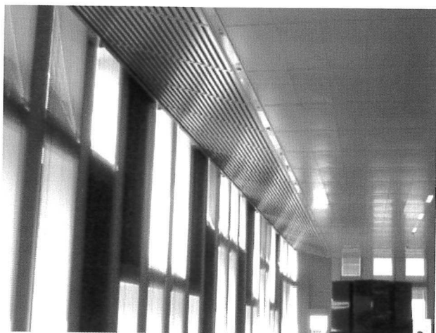
空調系統採天花板輻射冷房設計
