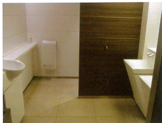
洗手檯區採 LED 照明及高照度節能設計
