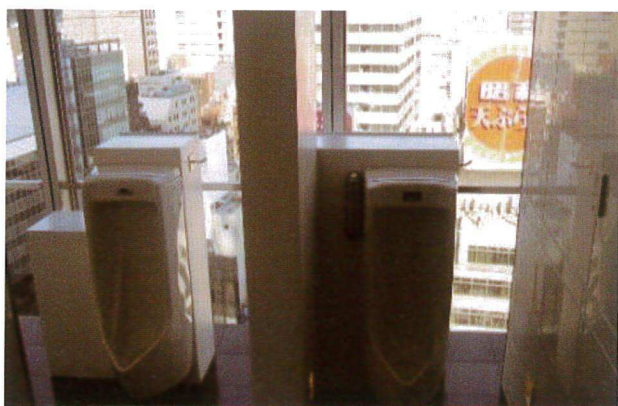
廁所外牆採透明玻璃窗自然採光節能設計
