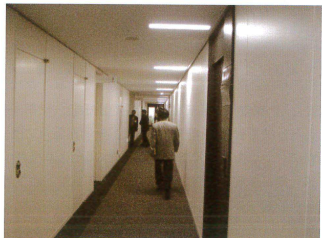
大樓公共走道照明採 LED 節能燈具設計
