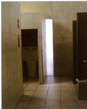
牆面垂直採光窗節能設計
