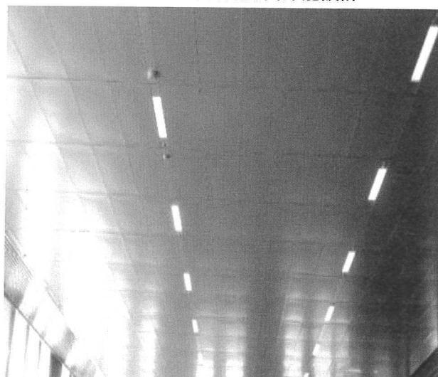
天花板採 LED 照明及高反射率節能設計
