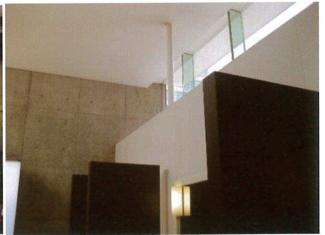
牆頂採大面積自然採光高窗節能設計
