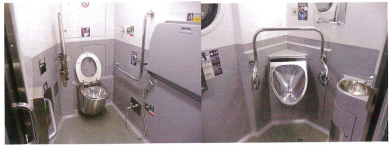
電聯車：便器扶手設置適當
