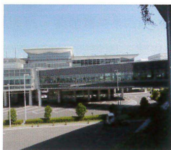
航廈通廊連結停車場
