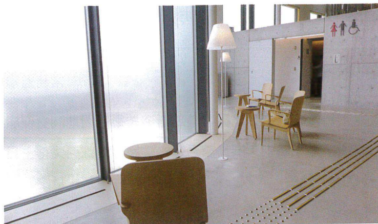
圖 2 地板出風口設置於與外環境接近處，且利用小單元可調出風方向達成舒適效益
