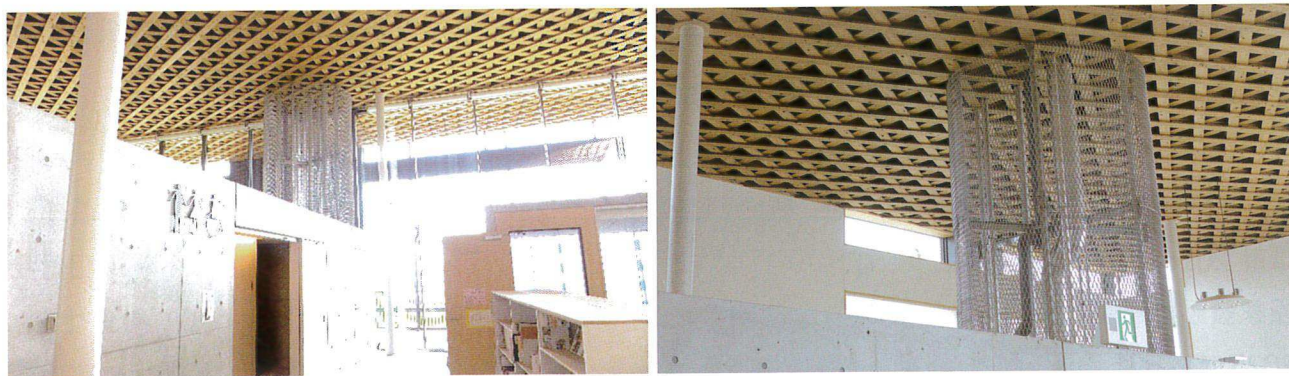
圖 5 廁所管路系統藉由網籠的通透設計，整合於室內開放空間當中避免突兀
