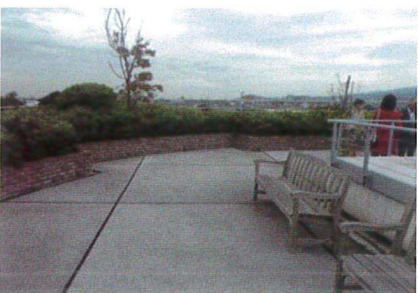
屋頂平台寒水石鋪面
