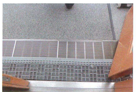
截水溝防止雨水進入室內
