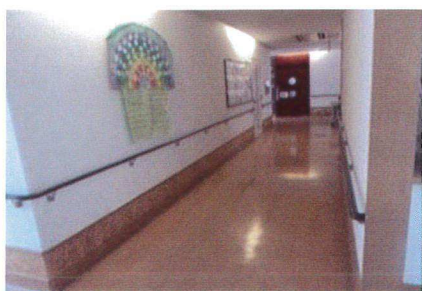
走廊二側牆面裝置扶手
