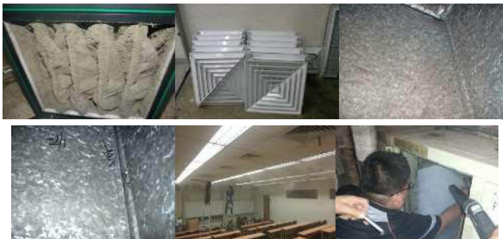
圖 33 中央空調系統清洗工作現況 (本研究整理)
