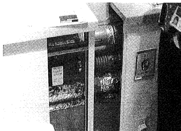
圖 4 背側的各式配管有：淨水管、排水管、冷水管、熱水管之展示
