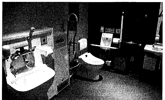
圖 8 日本 TOTO Technical Center 新設計的行動不便廁所，左角有人工肛門洗盆（OSTOMATE）行動不便馬桶側牆小洗手盆、沖水凡而、求救鈴，馬桶除了扶手外有靠背。馬桶與人工肛門洗盆中間有設一活動躺床可供脊椎重傷病患使用。
