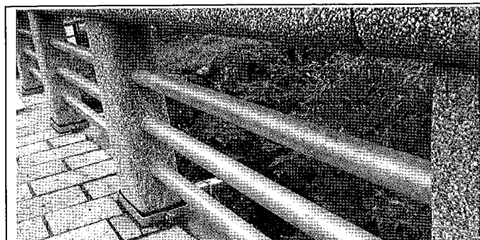
圖 34 天然材料抵石子與不銹鋼接合時之金屬脫漆情形
