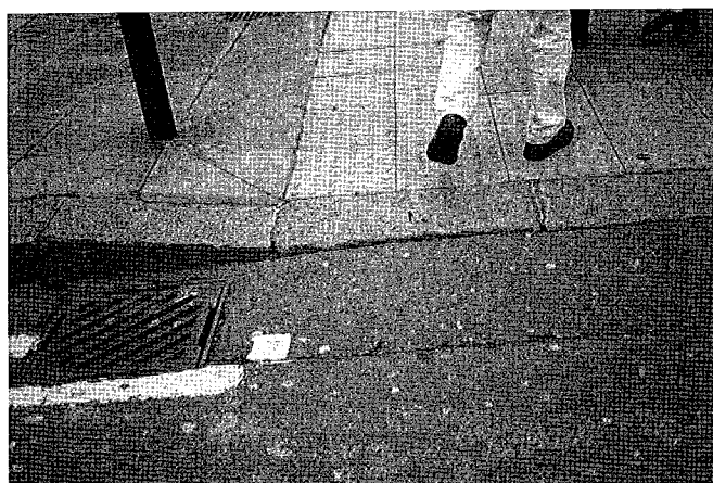
圖 8 步道和馬路的接合處之平順度可再加強
