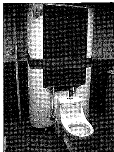
圖 16 廁所中水回收再利用系統圖與整合產品
