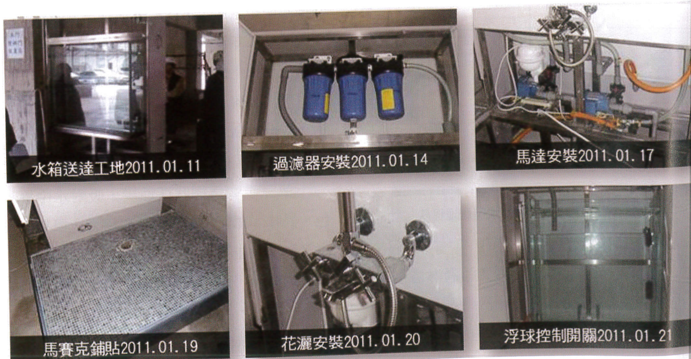
圖 12. 綠色水系統實體模型內部各項設施與設備裝設
