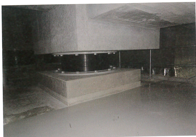
清水建設大樓地下室，隔震橡膠墊。
