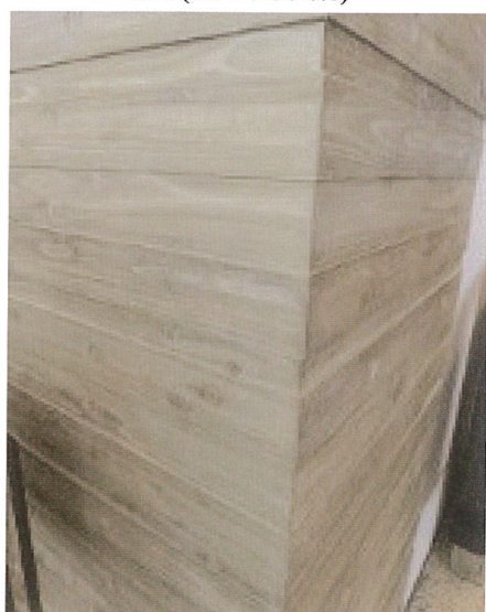
清水建設大樓，清水混凝土耐震牆，強度為 8000P.S.I 以上，模板故意錯置 5~6mm，並將杉木板紋路拓印在牆上，樸素清雅。
