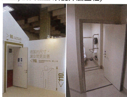
雙向如意門 快速夾牆式環保施工(門扇與五金和鋁合金門框已預先模組裁切組裝)
