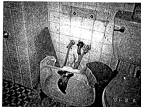
固定端之陶瓷板破裂案例
