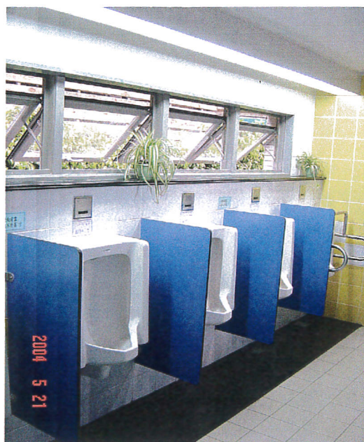
照片五·台博館 228 公園男廁小便斗上方有整排燈照明，且有窗可看外面景色，吊掛式小便斗下方置 50 cm 寬之黑色花崗石板固定其站位。(吳明修 攝)
