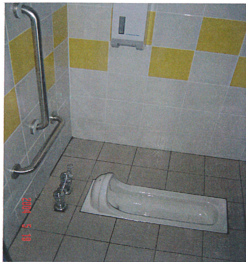
照片三・台博館 228 公園公廁 70 cm 加長型蹲式馬桶前方安裝倒 T 扶手（吳明修 攝）
