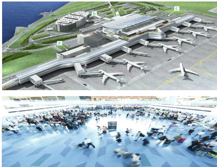
圖 1 羽田國際機場(資料來源：羽田國際機場 terminal 株式會社)
