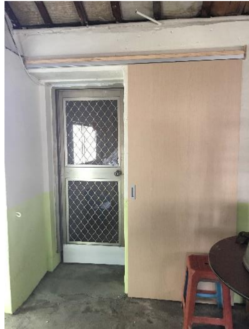
圖 5 修繕後門檻打除
