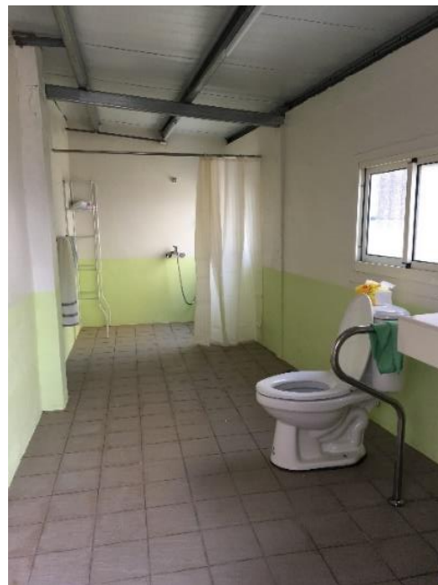
圖 3 改造後的浴廁
