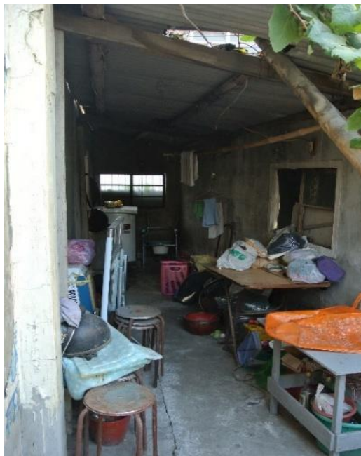
圖 2 改造前的儲藏間
