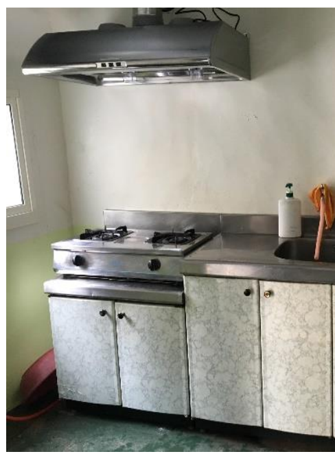
圖 7 修繕後的廚房
