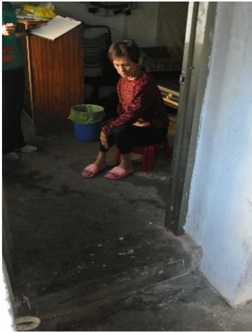
圖 4 修繕前的門檻高低差
