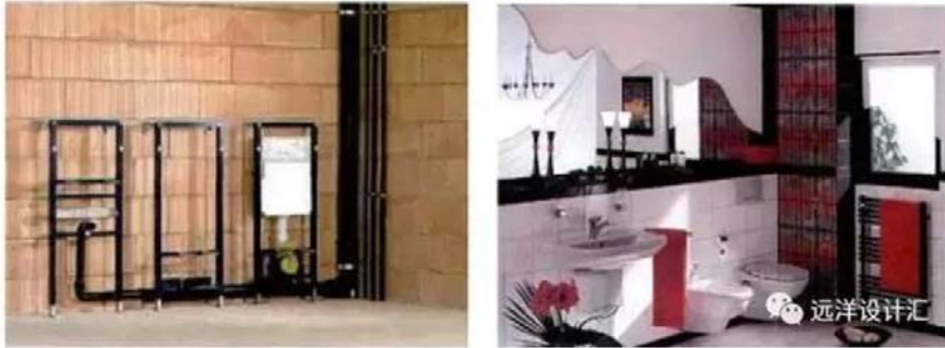
圖 7 牆排式衛浴空間室內各項潔具布置實況圖(資料來源：張弛，遠洋設計匯，「淺析同層排水在住宅建築中的應用」，構築空間文化傳媒，2017/06/06，原文網址： https://read01.com/yRGANM.html )
