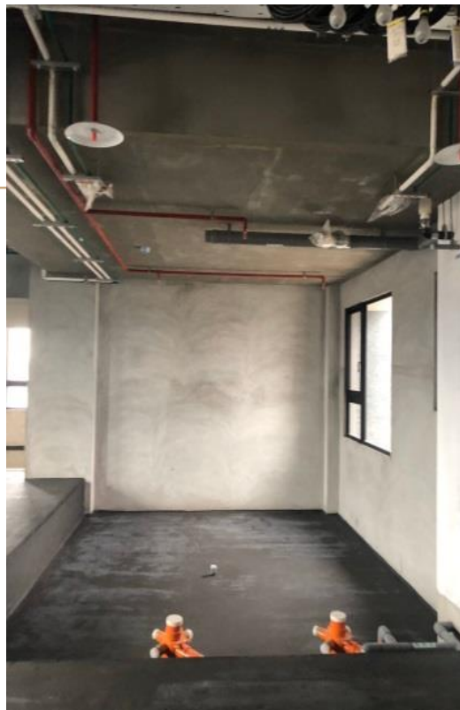
降板構造配管-無回填式
