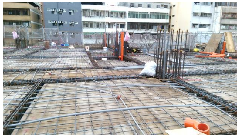
結構體樓板鋼筋綁扎
