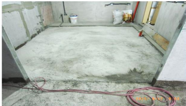
降板區輕質混凝土回填
