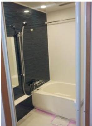
整體衛浴特點：快速、模組化、乾淨可移動。缺點：客製化較差
