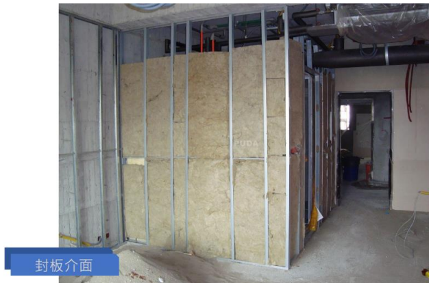
整體浴室組裝後的封板中圖
