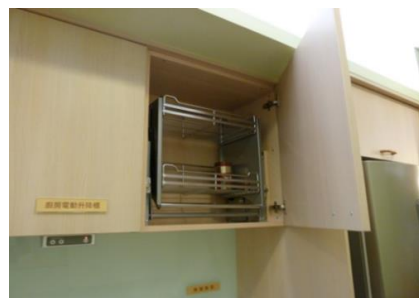
圖 3-9 調理台上櫥櫃收納空間採油壓可上下移動取用 (攝於長庚科大福祉系)
