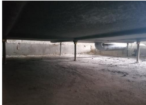
建築結構降板 23cm 後，整體浴室的底盤下方配管圖 (無需水泥砂漿填滿)
