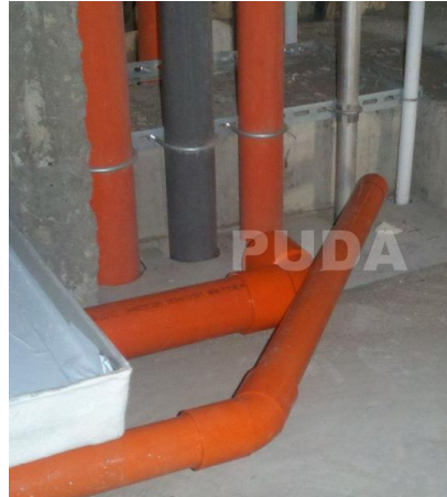
整體浴室下方排水管等待垂直排水管接管 (明管明線)
