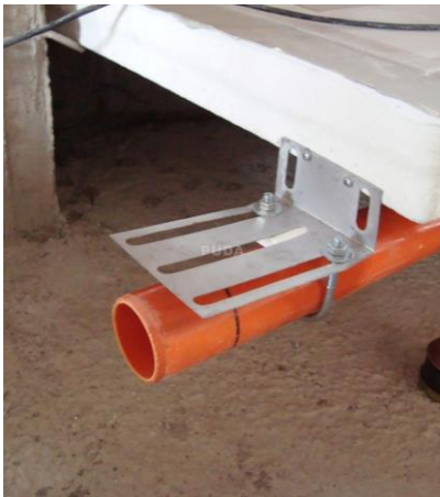
整體浴室下方排水管等待垂直排水管接管 (明管明線)
