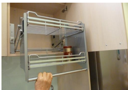
圖 3-9 調理台上櫥櫃收納空間採油壓可上下移動取用 (攝於長庚科大福祉系)
