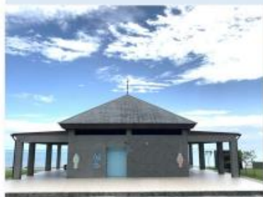
男、女入口分開設置，增加隱私及女性性，廁所管路重新配置，改善漏水、淤塞。
