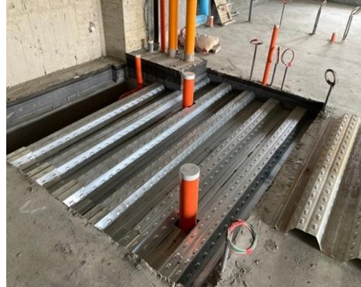
▲無回填型（隔板）降版同層排水
