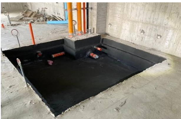
▲結構體防水施作
