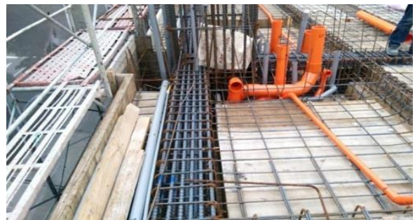
▲鋼筋綁扎（必要時補強）
