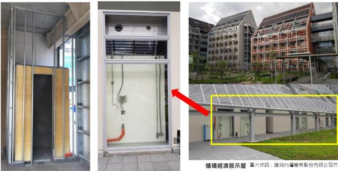
圖 14 模組化現地組裝廁所(卜大整體衛浴提供)
