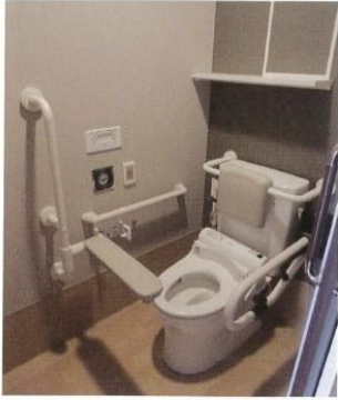
特別養護老人 Home，老人用馬桶、扶手、靠背外還要手肘板，電動沖水按摺及求救鈴在右側牆上。
