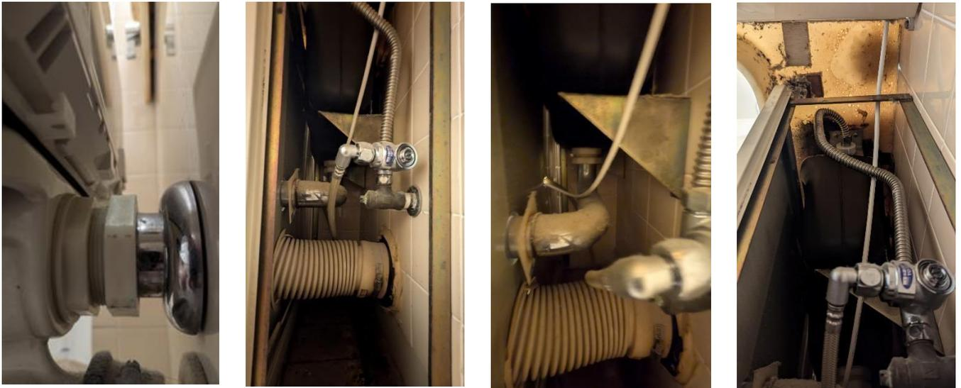
座式便器後方的後排式管道，可謂採用 UT 方式排糞管系統，水平方向糞管銜接至垂直管道間
