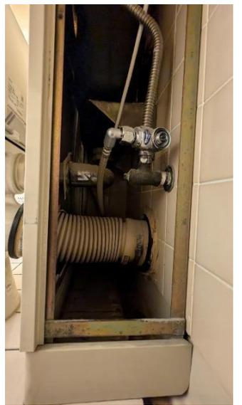
座式便器後方的後排式管道，可謂採用 UT 方式排糞管系統，水平方向糞管銜接至垂直管道間
