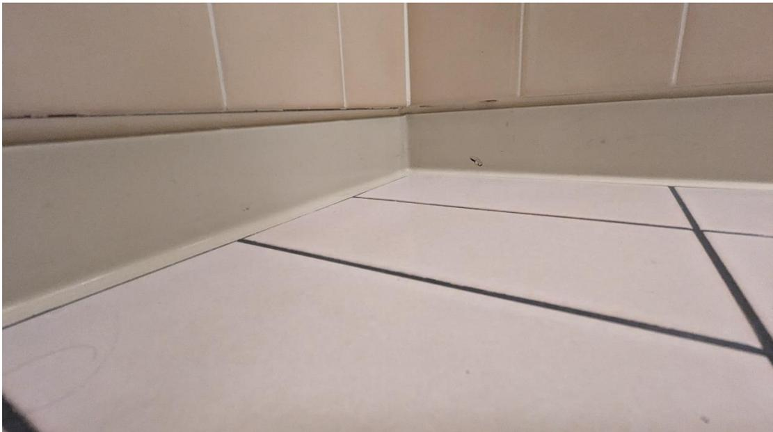
地坪的排水洩水坡度可在工廠廠製化過程準確調整
