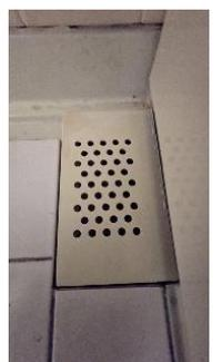
浴室地面排水渠道集中在座式便器、洗臉盆下方的角落，並配合浴室整體落水頭位置
