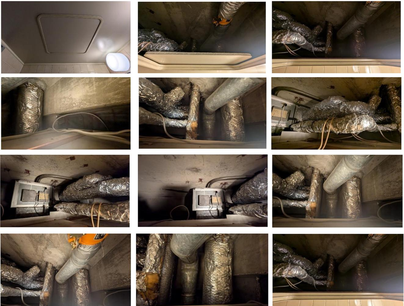
浴室頂版打開後，發現部分採用貫穿樓版的施工系統，大部分管線為供水管線為主
