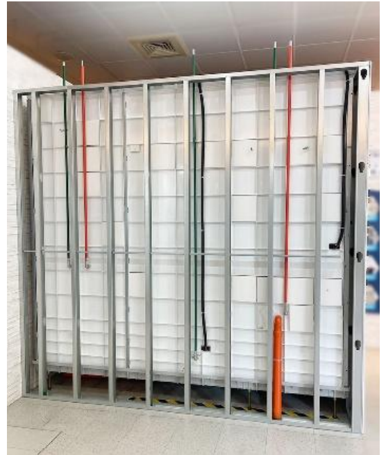
圖 4 背板結構管線銜接示意
