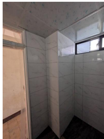
圖 2 傳統磁磚轉角完成圖
